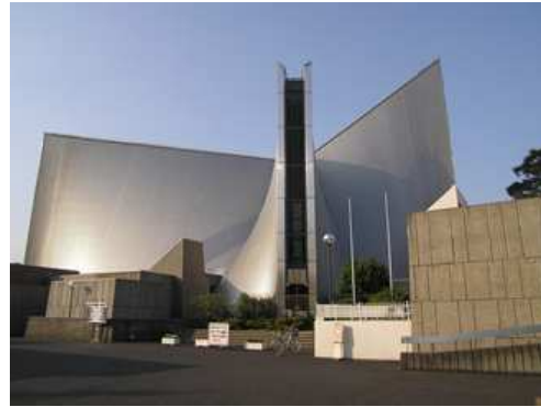
Imagen 19. Vista de una fachada lateral
