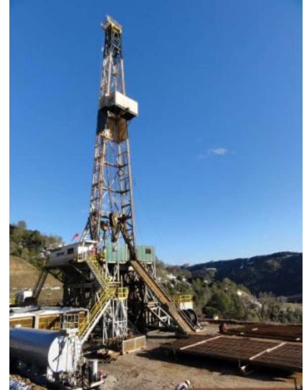
Fig. 8. Plataforma de perforación [Fuente]
