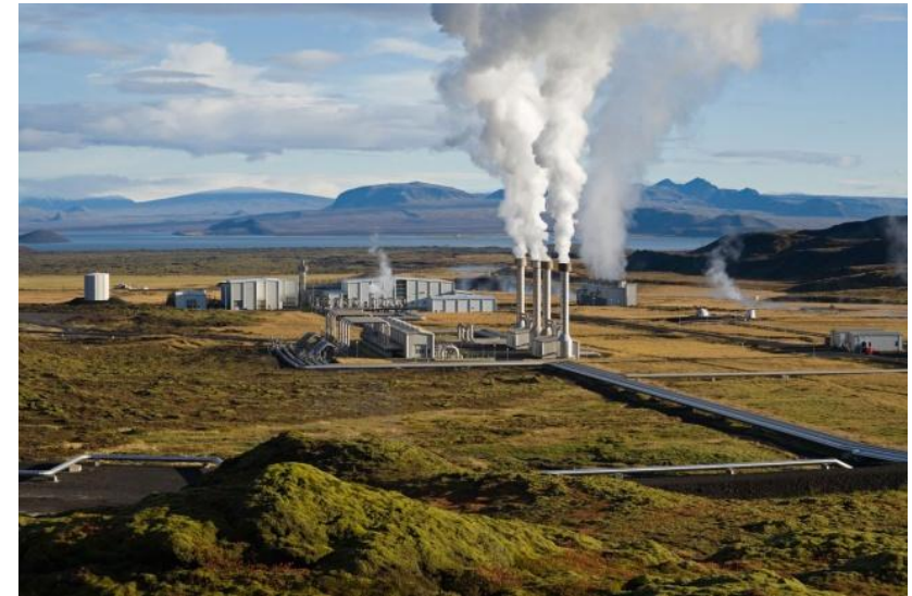
Fig. 9. Planta de Geotermia de Nesjavellir
