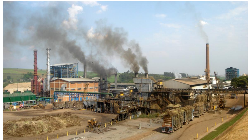
Fig. 16. Planta de biomasa. [ Fuente ]
