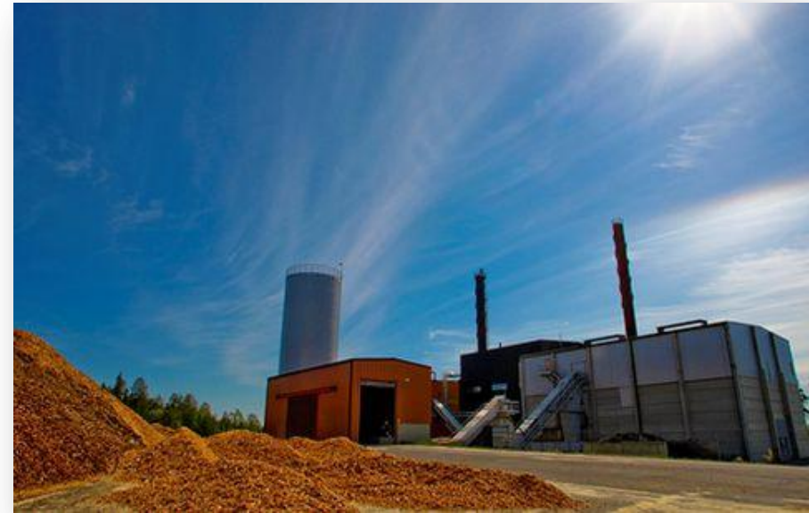
Fig. 7. Planta de Biomasa. [Fuente]
