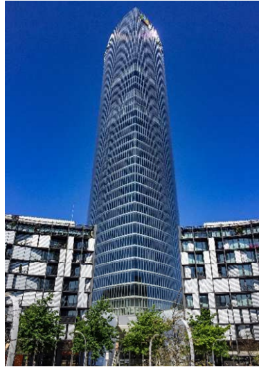
Imagen 4. Torre Iberdrola, Bilbao, Bizkaia (imagen propia)
