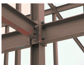
Estructuras en Construcción
