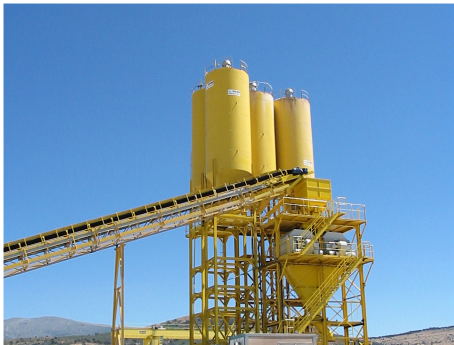
2.5. Irudia. Hormigoi fabrika bateko azpiegiturak ( http://victoryepes.blogs.upv.es/category/cemento/ ).
