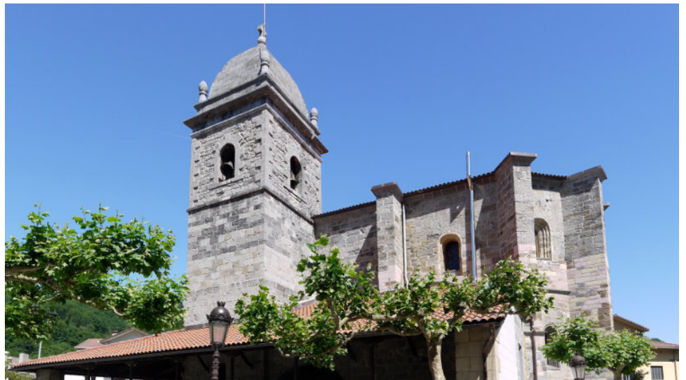
Vista general de la iglesia
