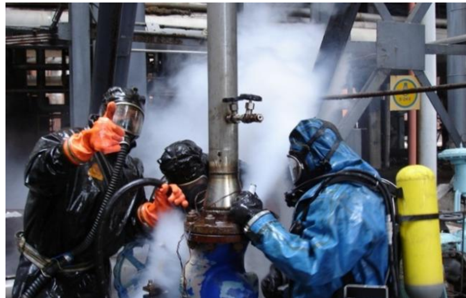
Figura 4.14. Reparación de una fuga de amoniaco en una planta de fertilizantes. Fotografía publicada en Wikimedia bajo licencia CC BY-SA 3.0 [10]
